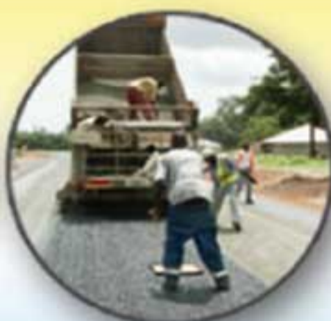
Aménagement de chaussées
